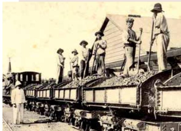
Des wagonnets transportent le minerai jusqu'au va-et-vient qui les conduit en bord de mer.
